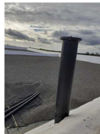
Casier CB10 (couverture avec géomembrane)
